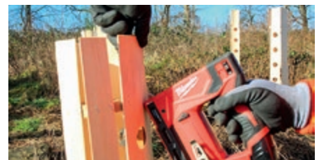
Die Befestigung der Hülle am Haltestab ist innovativ. Mit einem Akkutacker werden die Dendron dauerhaft stabil befestigt.
